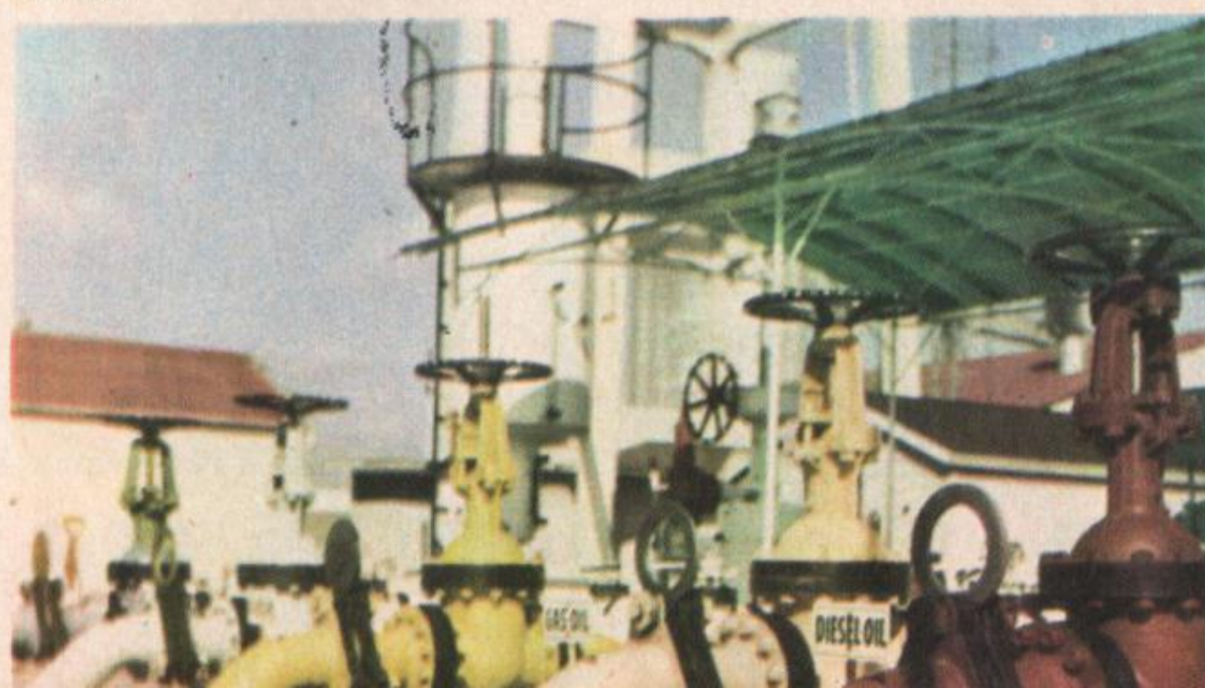
Bocas de bombas del Oleoducto La Plata - Dársena de Inflamables. Cada color indica el tipo de producto que se recibe.
