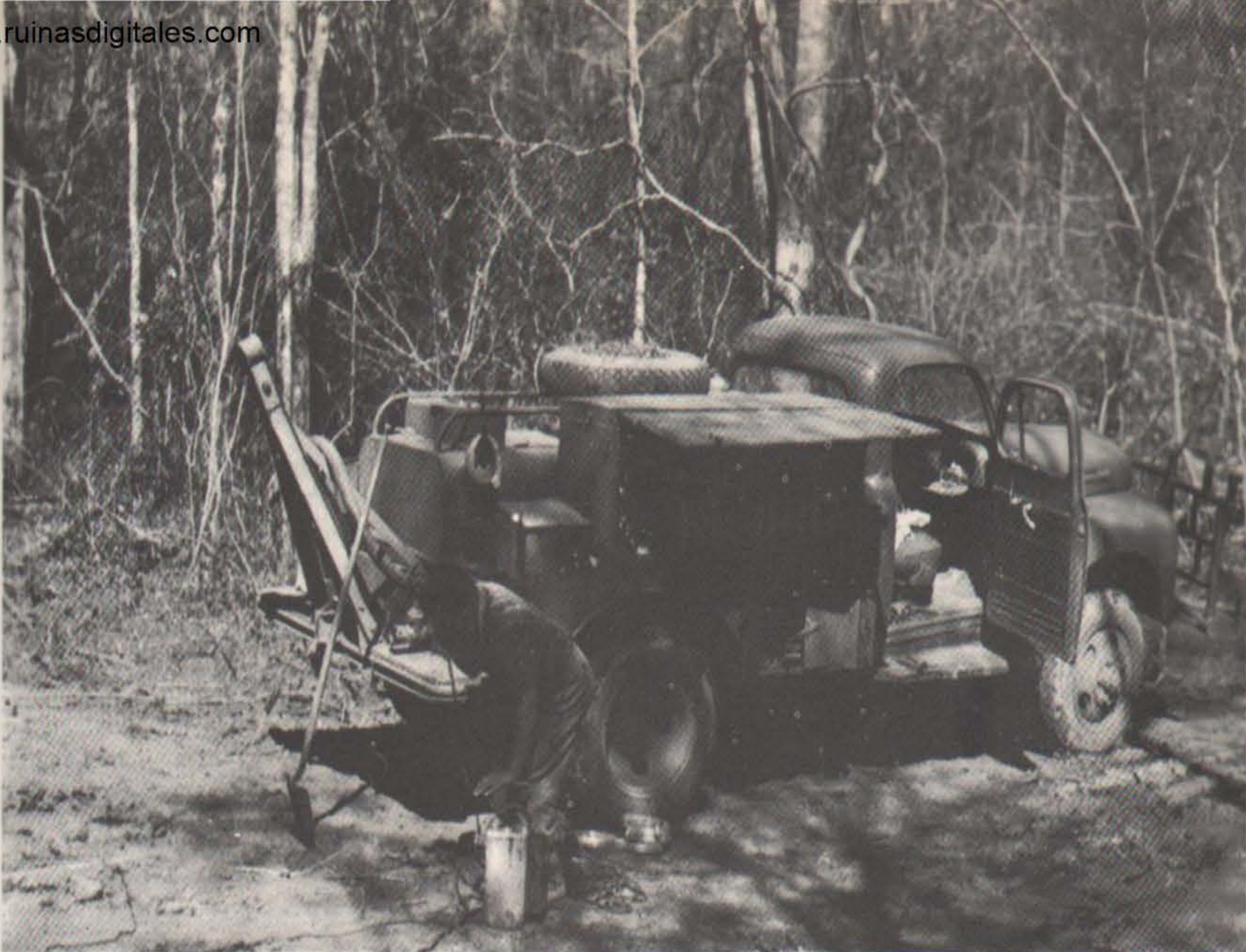
Labor de registraci3n s3smica de reflexi3n en una picada de la provincia de Salta.
