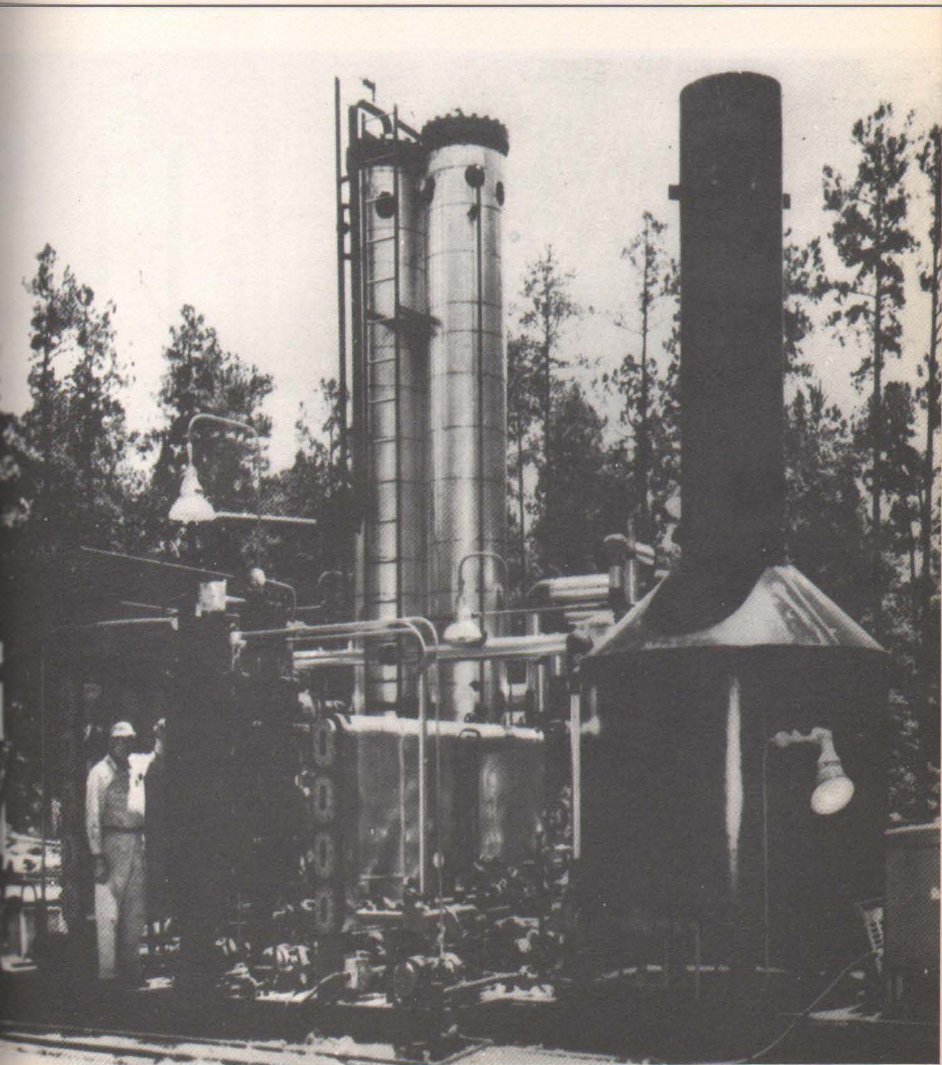
Destilería El Centauro, instalada en la Bahía de San Sebastián, Tierra del Fuego.
