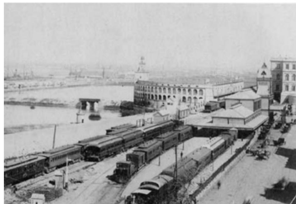
Figura 7: Vista de la zona costera en 1887, durante la iniciación de las obras de Puerto Madero. Se puede observar la progradación costera por relleno artificial sobre el río de La Plata para la construcción de Puerto Madero. En la fotografía se distingue la Estación Central, la Aduana Taylor y hacia la derecha el Paseo de Julio, actual Leandro N Alem.
