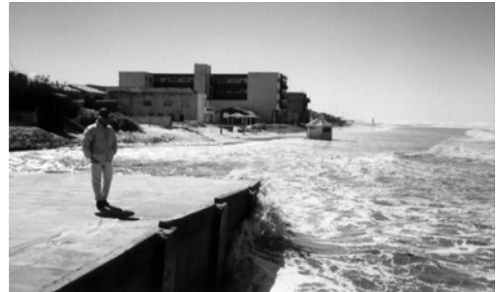
Figura 4: Exemplo de impacto frontal das ondas no calçadão de Cidreira. A face de Praia é submetida a um processo de rebaixamento e erosão pela energia de reflexão da alta energia das ondas durante a ressaca. Ao fundo observa-se a dissipação da energia das ondas favorecida pelo ainda existente campo de dunas frontais. (Foto Lummertz, 1999).
