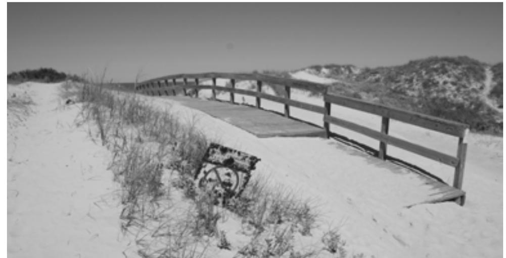
17: Detalle de acceso en madera (en parte destruído y tapado) construído sobre médano activo en playa Shangrilá (acceso Avda. Calcagno).
