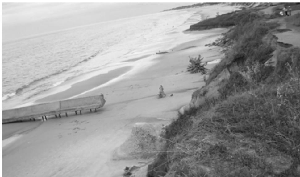
Figura 9: Vista del espigón Oeste descalzado en Las Vegas. Observese los intentos de contención mediante el empleo de raíces, enrocado. Escalera de acceso semitapada y punta de arcillas negras compactas al fondo. Foto: Diciembre de 2006.
