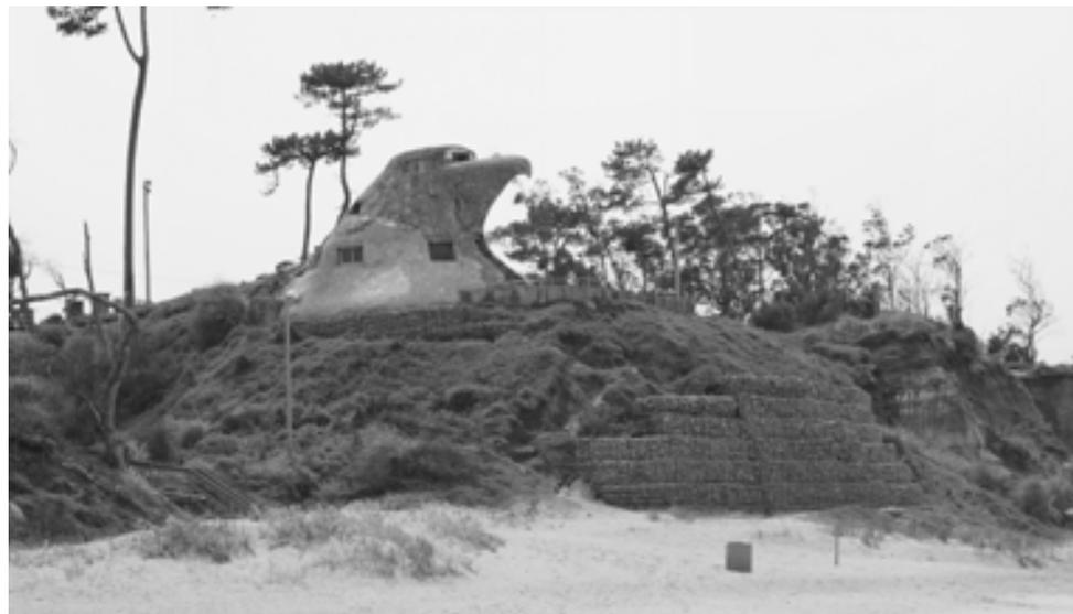
Figura 5: Vista del “Águila” y de la obra de contención de talud con gaviones. Foto: 2005.
