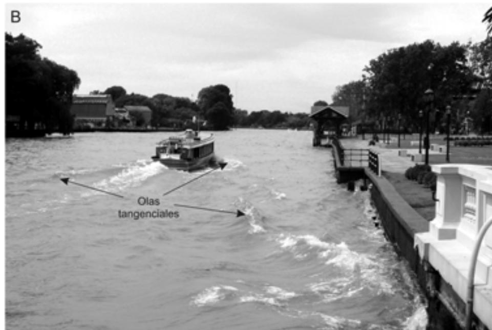
Figura 7.A: Efecto de las embarcaciones a motor como generadoras del oleaje. B. Ejemplo del efecto erosivo que producen las olas tangenciales de las lanchas pasajeras sobre los márgenes de los canales. Nótese asimismo la reflexión del oleaje sobre las estructuras verticales de protección de los márgenes.
