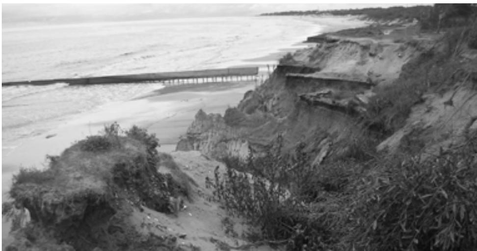
Figura 10: Vista hacia el Oeste (último espigón) en Las Vegas. Nótese como destrucción de rambla e ingreso del borde de acantilado en predio particular. Se observa paleosuelo cubierto por arenas eólicas subactuales. Fotos: Abril de 2010.
