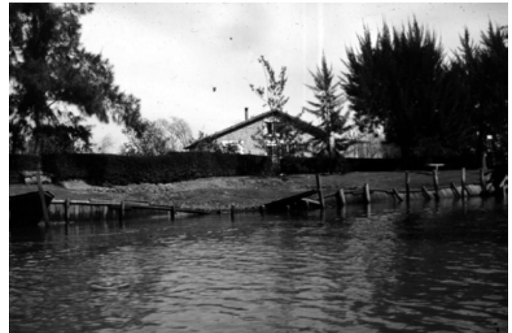
Figura 8: Colapso de estructuras por deslizamientos rotacionales favorecidos por la acción del oleaje de las embarcaciones
