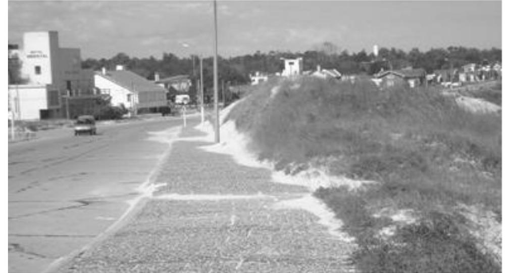
Figura 12: Detalle del avance de dunas sobre rambla de Playa La Floresta (Canelones). Se deben realizar tareas de limpieza frecuentemente para permitir la circulación vehicular. Foto: Setiembre de 2008.
