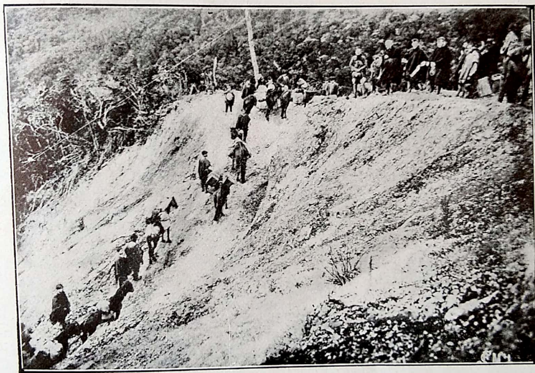
Una frana sulla strada di Mendez.
