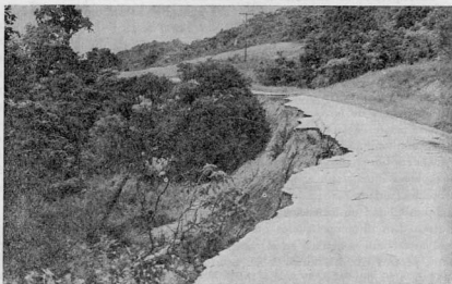
Fig. 11.11 Deslizamiento en el terraplén de una carretera debilitado por saturación.
