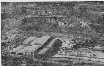
Fig. 11.19 Corrimiento de tierras producido por presión de agua en delgadas vetas de limo no cohesivo y arena fina en un grueso estrato de arcilla.
