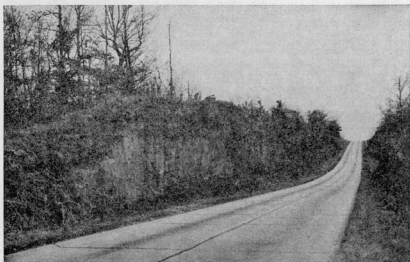
Fig. 11.10 Corte en loess en una carretera. Nótese el talud vertical y los amplios aco- tamientos.
