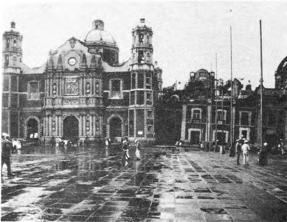
Asentamiento debido a Consolidación
