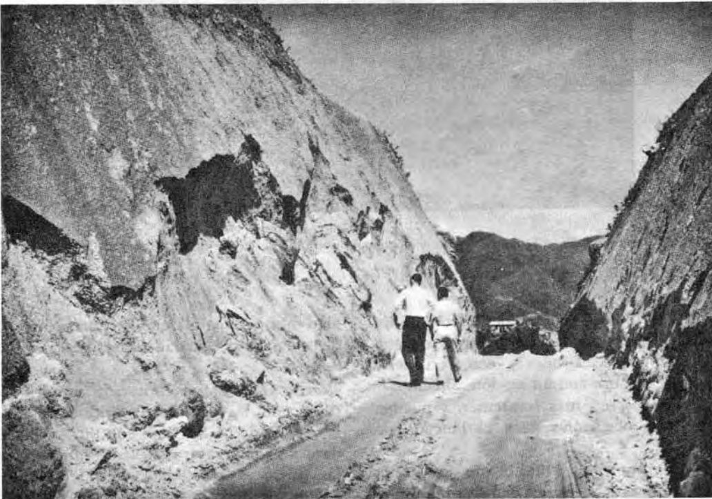
Figura 6.35. Derrumbes en suelos tropicalmente alterados producidos por discontinuidades en la roca madre.
