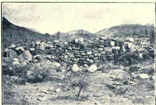
FIG. 19 Muro de separación de una casa con otra. El material aquí utilizado es piedra de cara y laja en su mayor parte.
